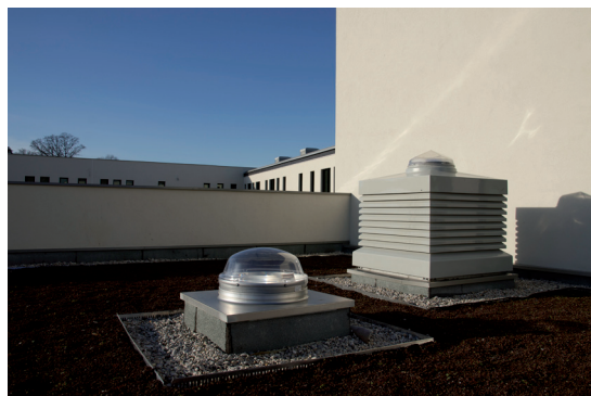
Systèmes de ventilation naturelle (Monodraw) et d'éclairage naturel (solars pot) Bourgoin-Jallieu, Groupe scolaire Diederich / Tekhnè architectes
